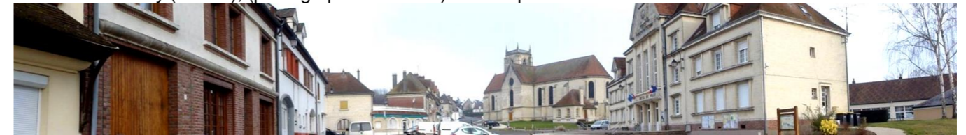
L'église réglementée de Longpré-les-Corps-Saints (MH 131) est complètement inscrite dans le village et le fond de vallée.
