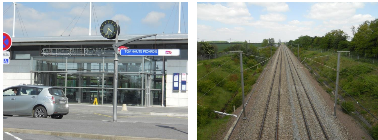
Figure 52 : Illustration de la Gare TGV Haute-Picardie et de sa voie ferrée (©ATER Environnement, 2014)
