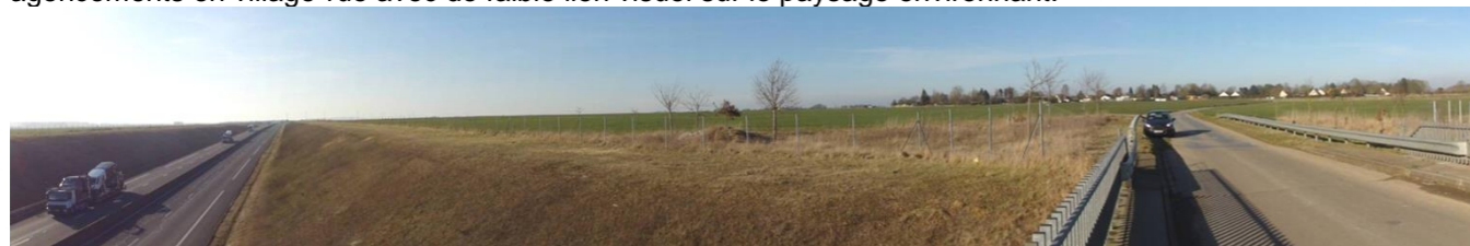
Perception sur le pont de l'A 29, autoroute bordée de talus autoroutiers, perception lointaine très limitée.
