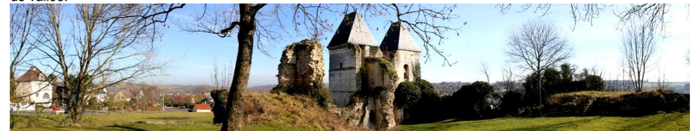
Depuis l'intérieur du château réglementé d'Airaines (MH 37), les co-visibilités avec les parcs éoliens existants sont déjà effectives (non visibles sur la photo, les éoliennes existantes sont objectivement visibles sur le terrain)
