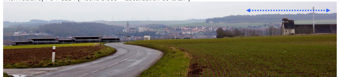
Vers Chaussée-Tirancourt, RD 49, avec vue sur le site emblématique de Picquigny, (Limite du périmètre intermédiaire) PDV 9306 (Flèche bleue = Localisation de la ZIP)
