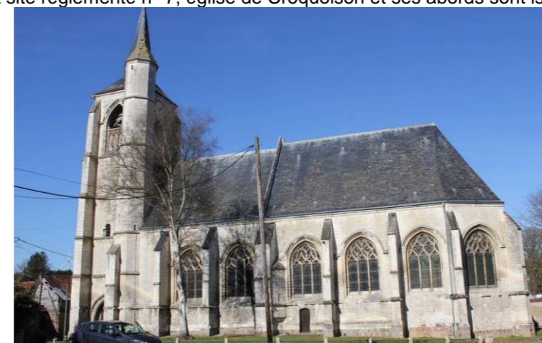
MH 40, église réglementée d'Allery (MH décrit dans le prochain chapitre à l'échelle du paysage rapproché) Figure 43 : Illustration de monuments historiques de l'aire d'étude intermédiaire. (source : Delphine Déméautis, 2015)
