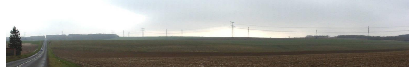
RD 12 entre Amiens et Saint Vaast-en-Chaussée, paysage largement anthropisé par les hauts pylônes et les nombreuses lignes électriques.
